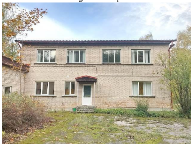
Administratīvās ēkas 009 ārskats
